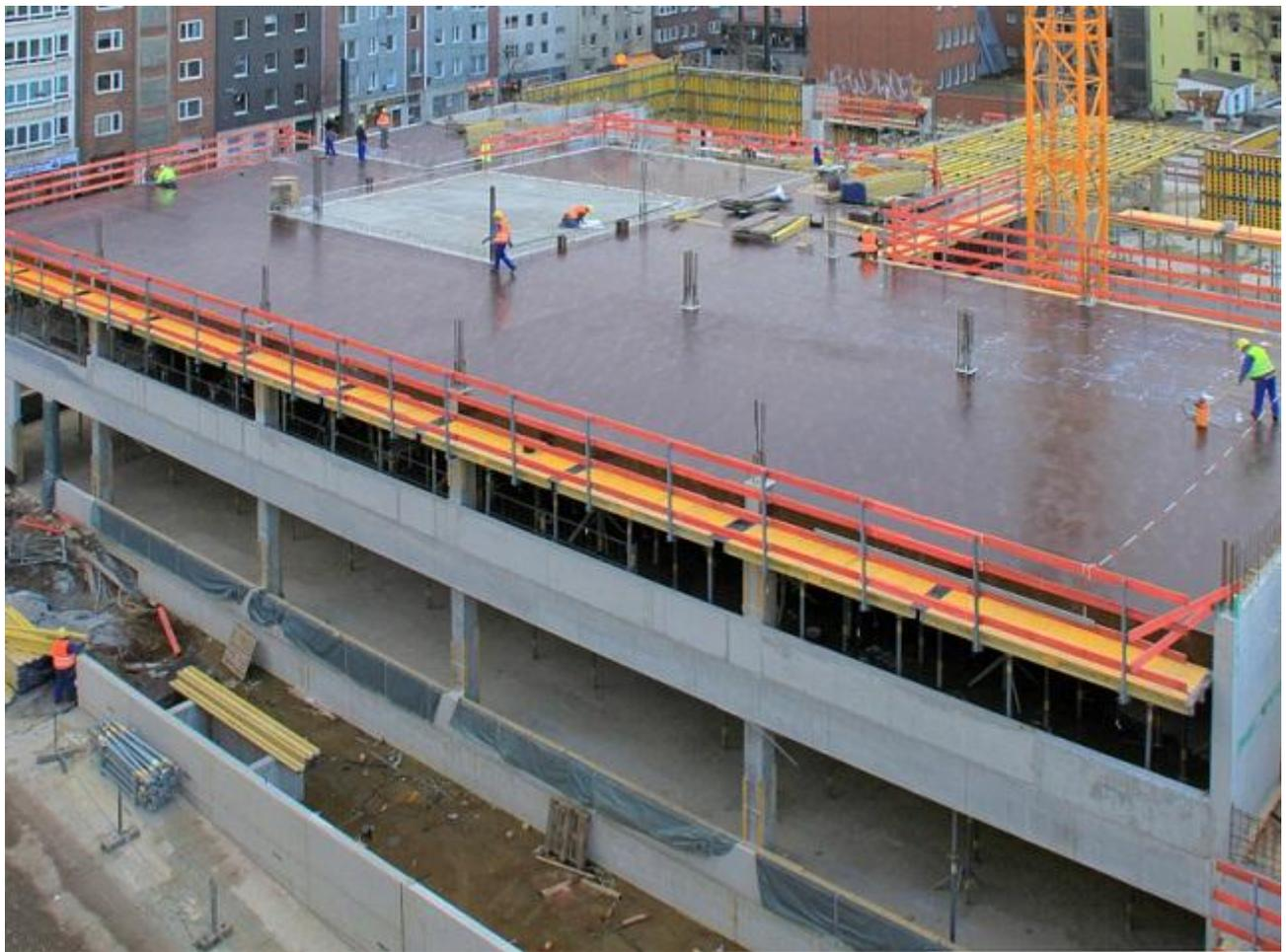
Die Betonage der 35 cm starken Decken des Campus Derendorf erfolgt in Abschnitten bis zu 2.000 m<sup>2</sup>. Foto: Doka
