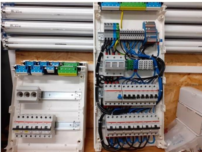
Bild 2 - Erstellte Elektrounterverteiler für ein Forschungsprojekt
